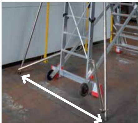
Zwolnienie stabilizatora. Open stabilisers.
